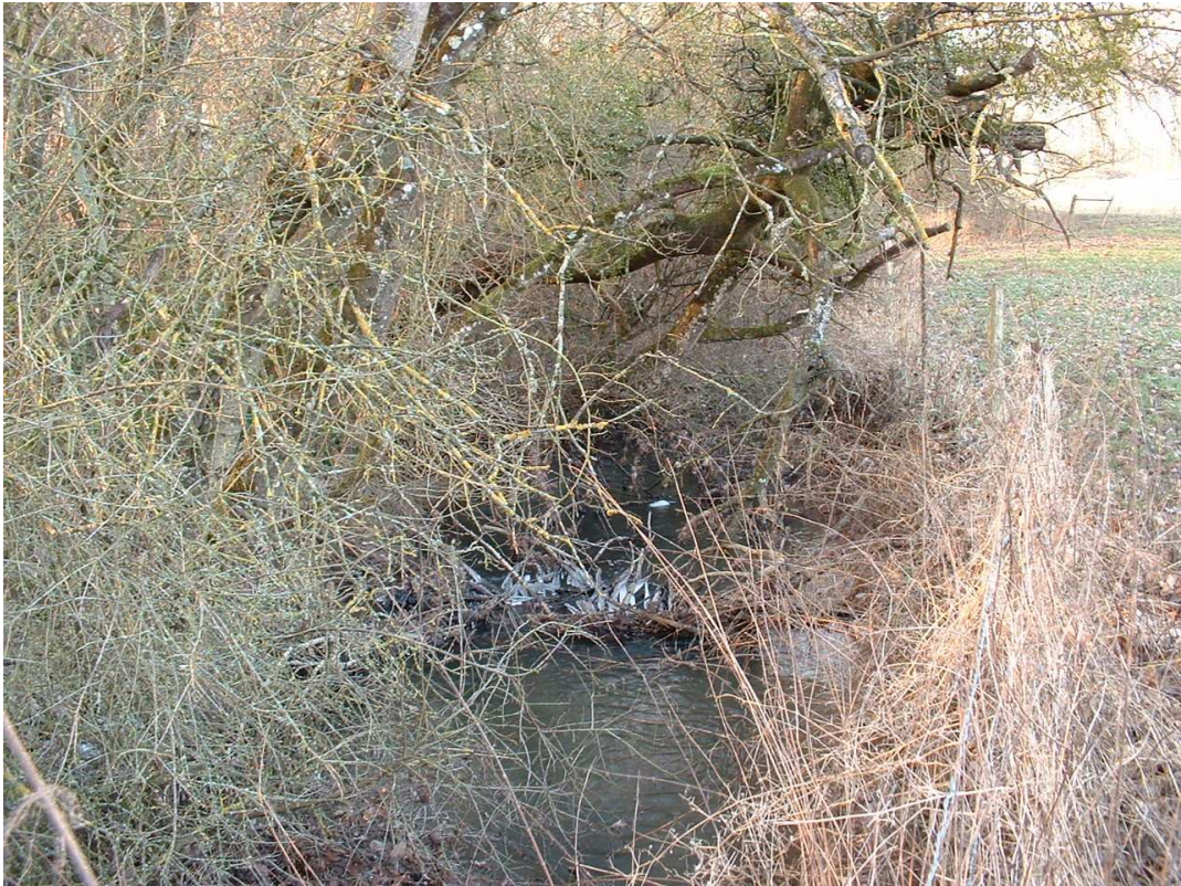
Avant travaux : embâcle provoqué par des arbres déracinés en retrait du ruisseau et par des aubépines qui retombent dans le lit.
