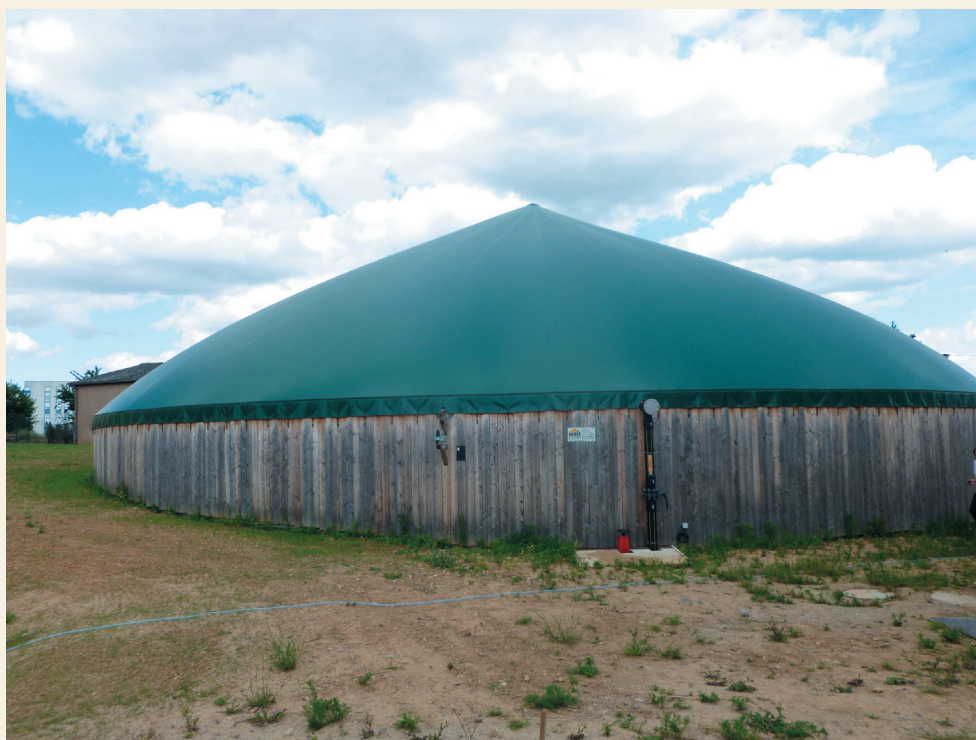
Fosse couverte par une bâche
