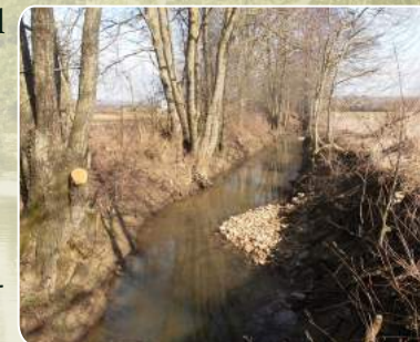
Travail de restauration
