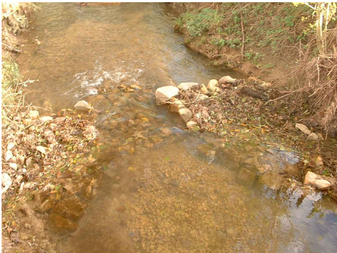
Déflecteurs vis à vis et apport de gravier
